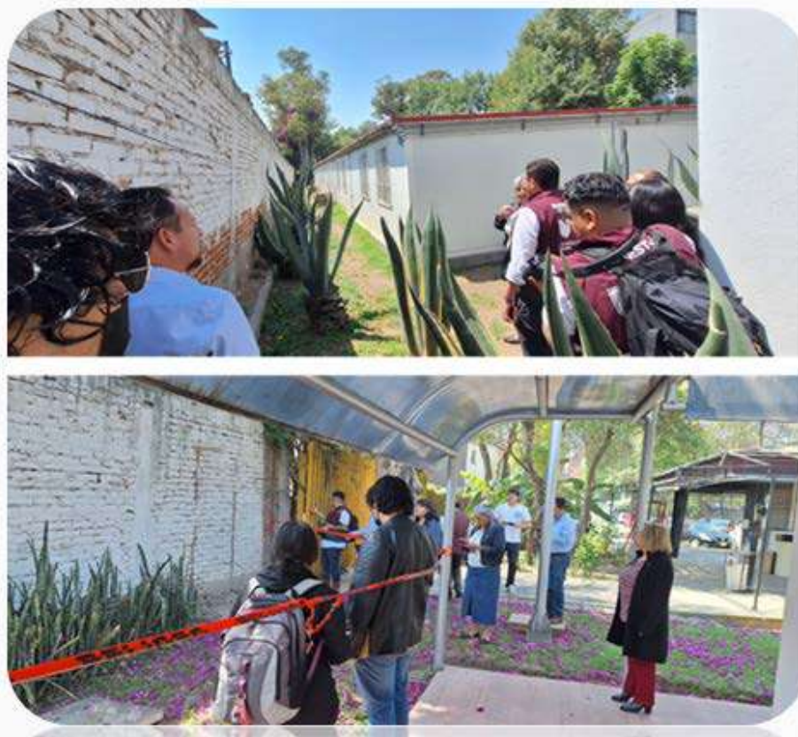
Ilustración 23. Revisión de la barda perimetral
