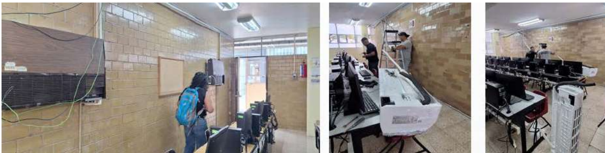
Ilustración 24. Instalación de aires acondicionados en aulas
