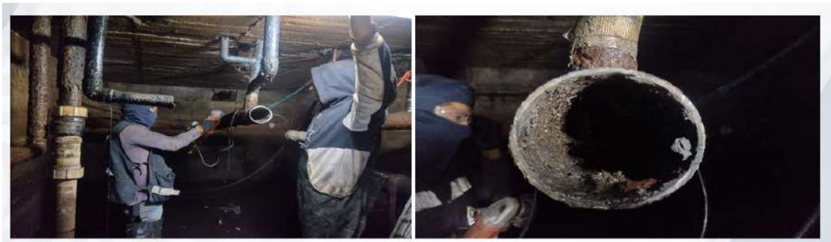
Ilustración 18. Mantenimiento a la red hidrosanitaria del edificio "A"
